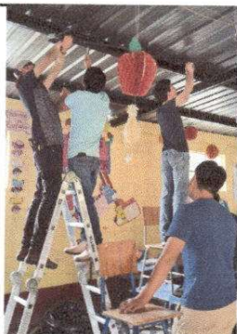
Foto 15: Reparación de cableado electrico
