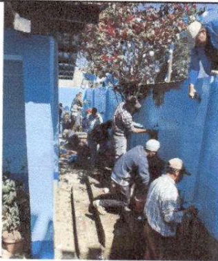
Foto 9: Pintura en muros exteriores.
