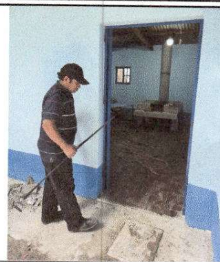
Foto 2: Sustitución de puerta.
