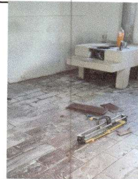
Foto 6: Sustitución de piso ceramico.
