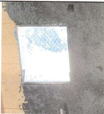
Foto 3: Sustitución de ventanas de madera por metal mas vidrio.
