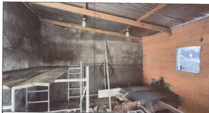
Foto 18: Repello en muro.
