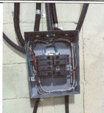
Foto 14: Sustitución de talbero de flipones.
