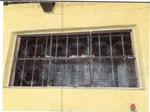
Foto 4: Sustitución de vidrios.
