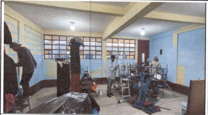
Foto 8: Pintura en muros interiores.
